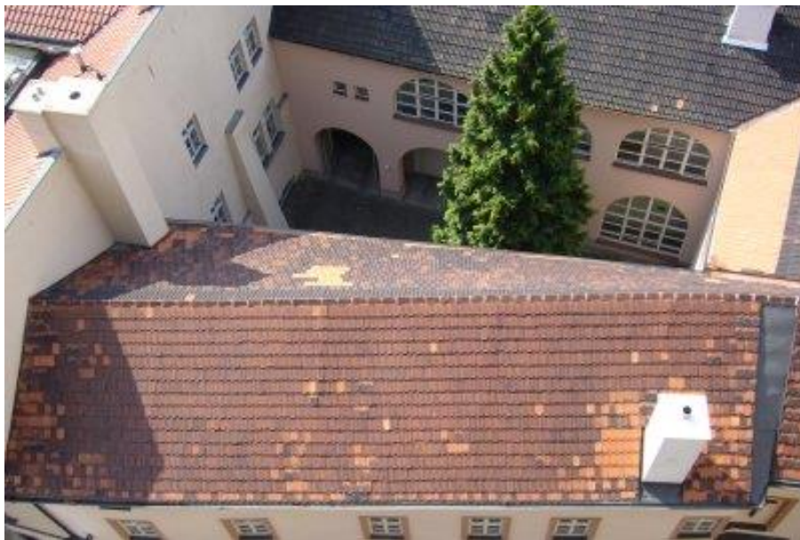
Sřechy na historických stavbách: vodorovný okap i hřeben střechy
