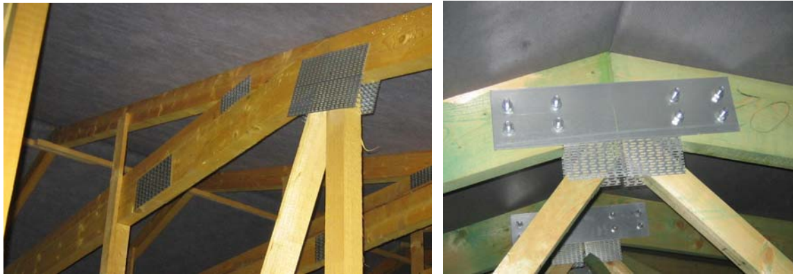
Obr. 12 Riešenie spojenia častí väzníkov v návrhu č.1(vľavo) a návrhu č. 2 (vpravo)
