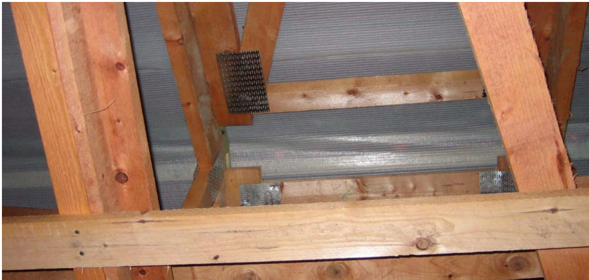
Obr. Prerušenie zavetrovacieho väzníka
