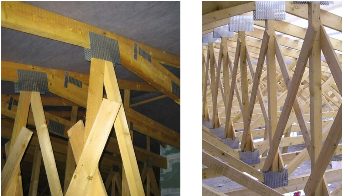
Obr. 15 ukážka aplikovania stuženia
