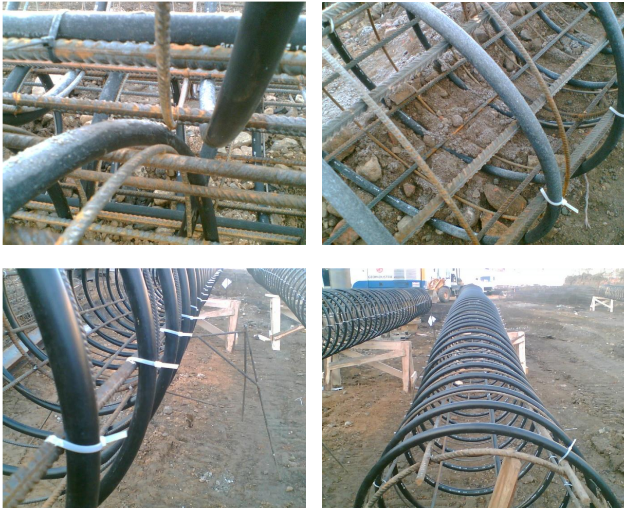
Obr. 12: Vystrojení energetických pilot potrubím ve šroubovici
