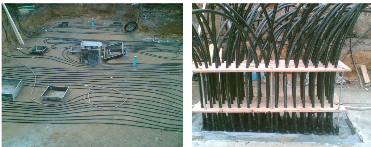
Obr. 14: Propojení potrubí energopilot s rozdělovačem/sběračem.
