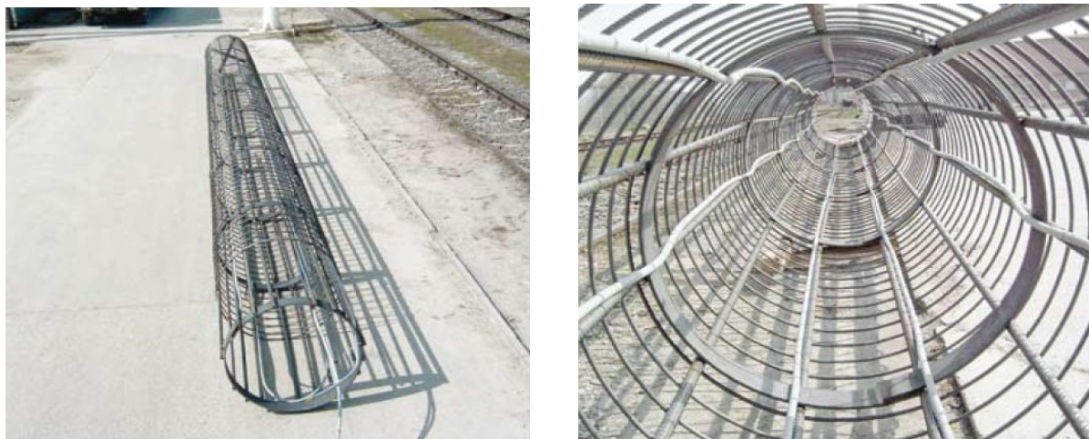
Obr. 4: Energetická pilota - vstrojení
