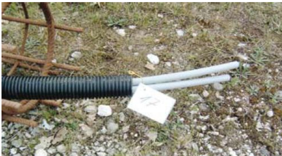
Obr. 7: Spojení přítoku a odtoku v chráničce
