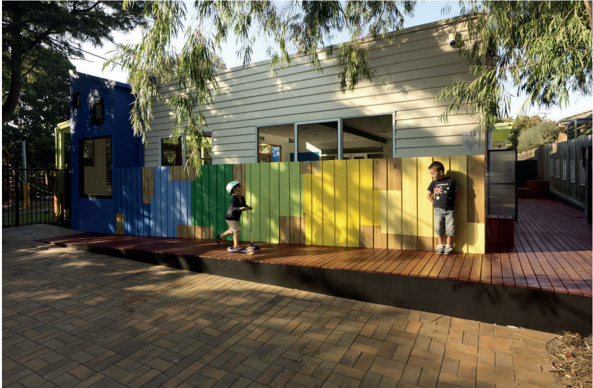
obr. 7.26 Mateřská škola Grande Road, Melbourne, exteriér / Archdaily
