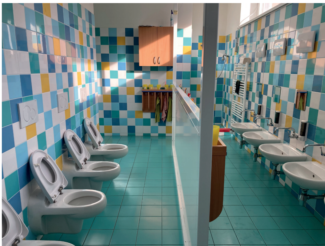
obr. 6.9 Mateřská škola U Nové školy, umývárna / archiv autora
