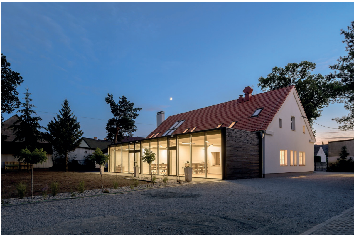
obr. 7.9 Mateřská škola Opole, exteriér / Archdaily
