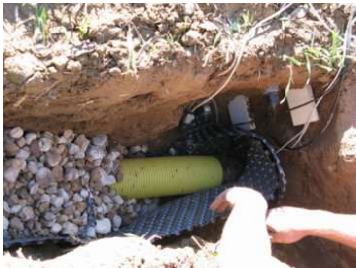
Obr. 15: Instalace drénu na půdním rozhraní (foto: archiv katedry K143)
