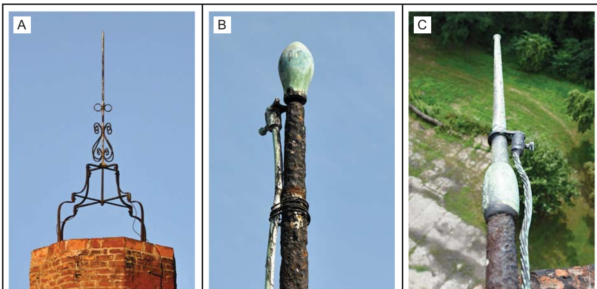
Obr. 49: Starší typy jímacích tyčí. A: Pivovar, Černčice. B: Pivovar, Lobeč. C: Parní čerpací stanice, Šilheřovice (→ 6998).
