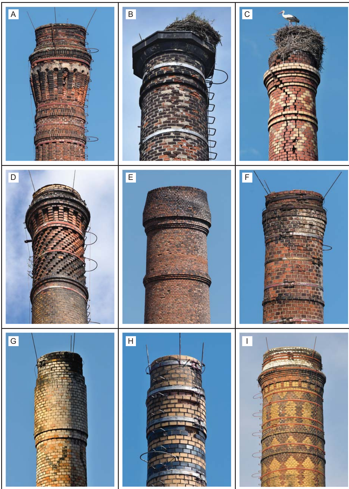
Obr. 39: Hlavice oblých komínů. A: Mechanická tkalcovna, Geipel & Jäger, Aš. B: Panská škrobárna, Habry-Zboží (→ 534). C: Cihelna, Jan Lemberk, Slatiny (→ 371). D: Mechanická tkalcovna, Brüder Richter, Varnsdorf. E: Důl Jindřich, Karviná-Doly. F: Zemský ústav choromyslných, Praha 2-Nové Město (→ 1010). G: Cihelna, Vlastimil Sachl, Domoušice-Solopysky (→ 1038). H: Pila, Mariánské Lázně. I: Kartounka, barvírna a apretura, Rollfs & Cie., Frýdlant.
