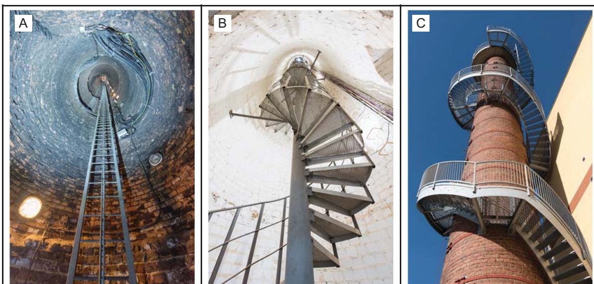
Obr. 72: Různé podoby nových vertikálních komunikací instalovaných v průduchu i venku na dřívku (všechny tři případy patří mezi jediné známé realizace svého typu u nás). A: Cukrovar, Lázně Toušeň. B: Kotelna, Olomouc-Povel. C: Zahradnictví, Brno-Komárov.
