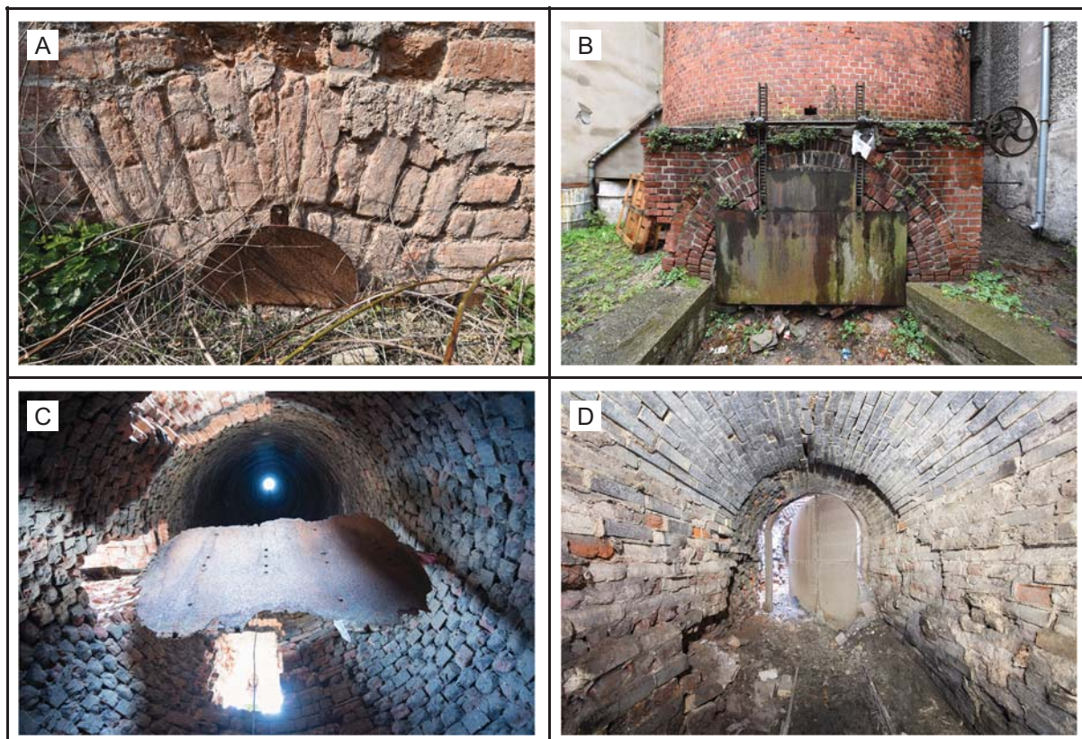
Obr. 50: Různé regulační prvky. A: Hradítko bez dochovaného ovládání. Parní cihelna, Ludvík Sochor, Ivanovice na Hané (→ 317). B: Hradítko v odhaleném kouřovodu. Přáderna jutí, Jaroměř. C: Klapka v dolní části průduchu. Cukrovar, Brodce (→ 3588). D: Klapka v kouřovodu (pohled od sopouchu směrem ke kotelně). Barevna a apretura, Feigl & Widrich, Chrastava (→ 540).
