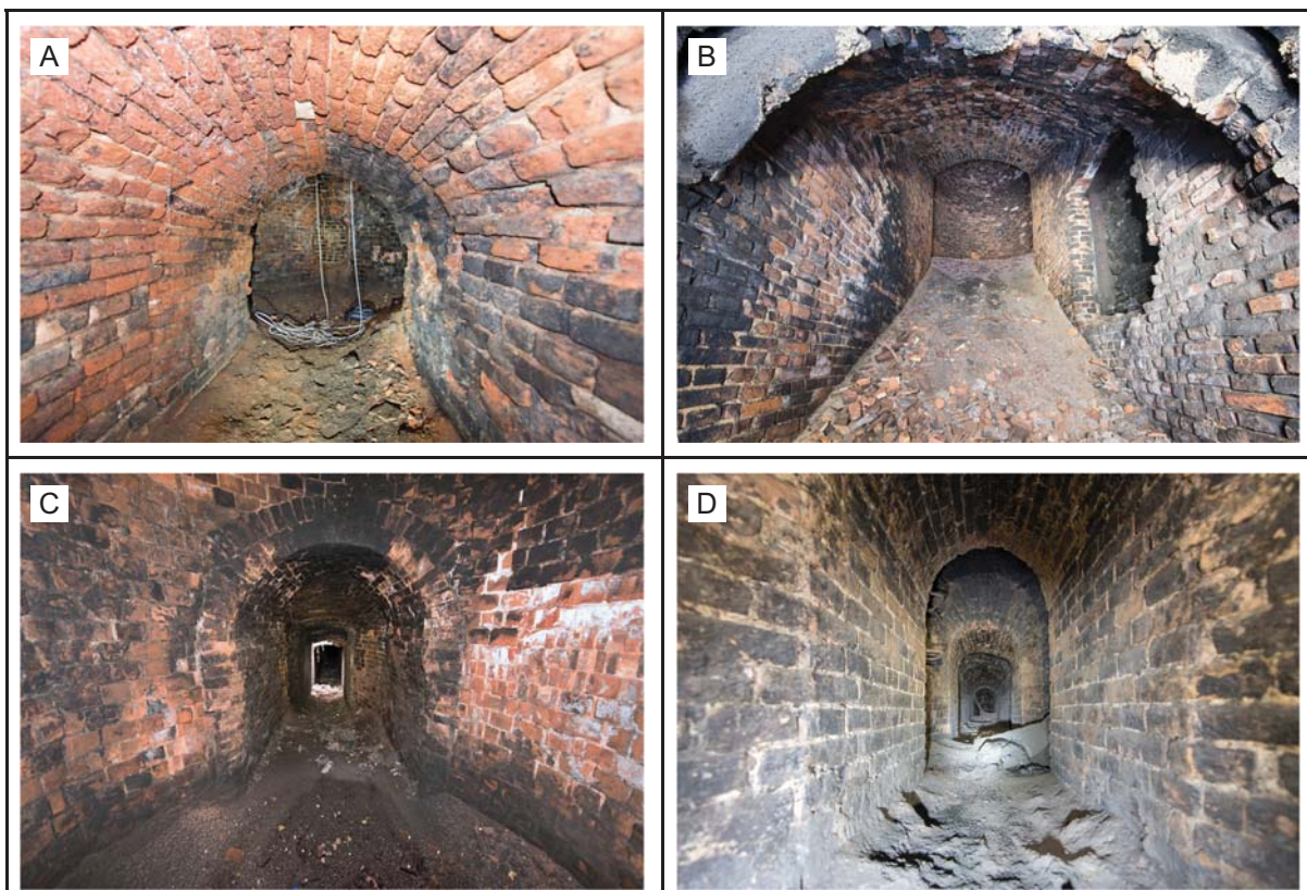
Obr. 22: Ukázky kouřovodů a sopouchů. A: Pohled z kouřovodu směrem do průduchu komína. Přádělna bavlny, Stein, Roztoky (→ 324). B: Pohled z kouřovodu směrem do průduchu komína. Barevna a úpravna přize, Herrmann Müller, Hrádek nad Nisou (→ 388). C: Pohled ze dna komína směrem do kouřovodu. Přádělna bavlny, Slaný (→ 113). D: Centrální kouřovod umístěný v podélné ose kruhové pece, pohled směrem ke komínu. Cihelna, Konečný & Nedělník, Držovice (→ 20).
