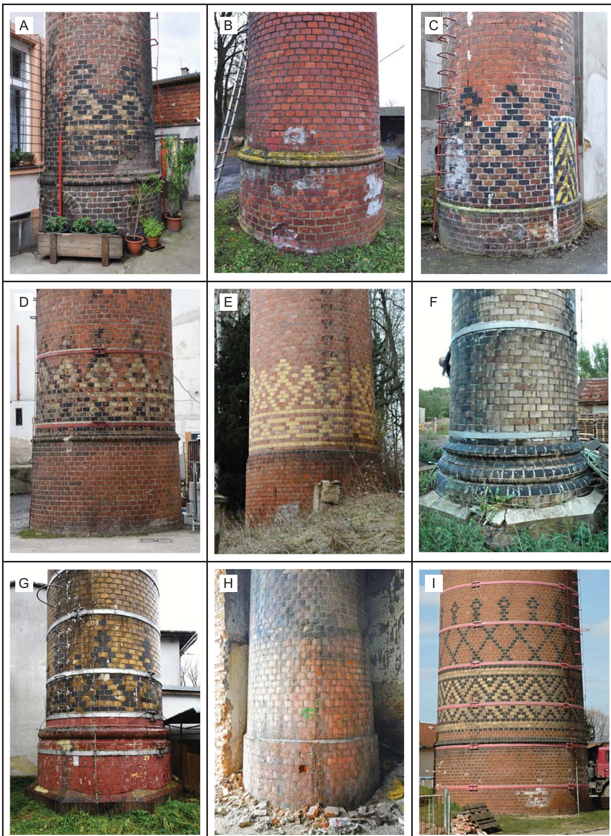
Obr. 33: Jednoduché oblé podstavce a sokly. A: Továrna na klobouky, O. F. Hess, Praha 8-Karlín. B: Sklárna, K. Rückl, Nové Mitrovce. C: Mechanická pletárna, J. Stutz, Chlumeč nad Cidlinou (→ 1015). D: Továrna na čokoládu, cukrovinky a kávové náhražky, Velim (→ 350). E: Královský zemský ústav pro choromyslné, Kosmonosy. F: Tkalcovna bavlny, L. Dormitzer, Perštejn-Černýš. G: Textilní továrna, Jiříkov. H: Parní pila, Fr. Živec, Kostelec nad Černými lesy. I: Vodárny hl. města Prahy, Káraný.
