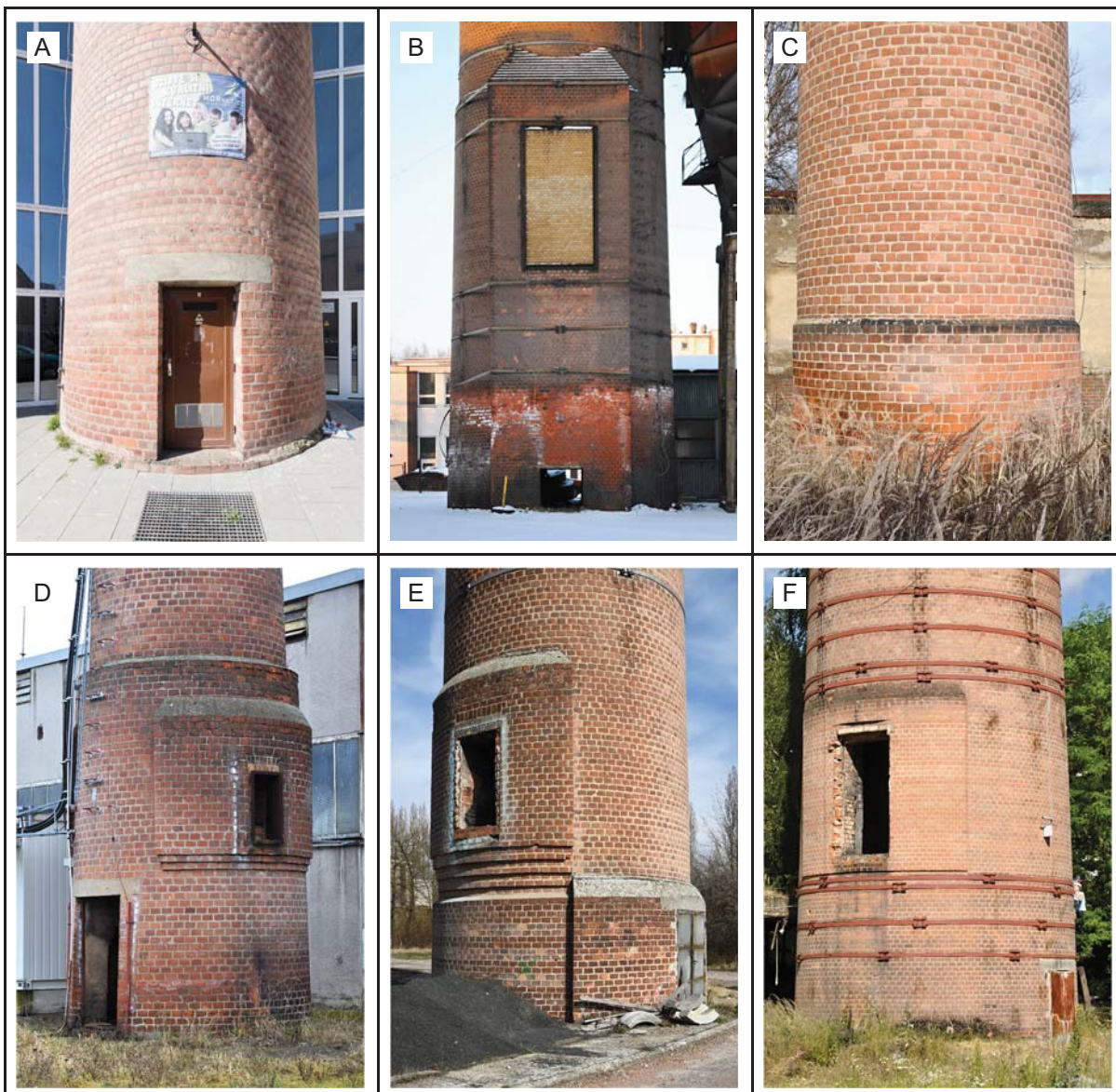
Obr. 34: Podstavce (s případnými portály) komínů z druhé poloviny 20. století. A: Kotelna, Olomouc-Povel. B: Kovohutě, Mníšek pod Brdy (→ 3040). C: Masokombinát, Louny. D: Vojenský útvar, Lišice. E: Porcelánka, Klášterec nad Ohří-Miřetice u Klášterce nad Ohří (→ 2811). F: TIBA, Josefův Důl.
