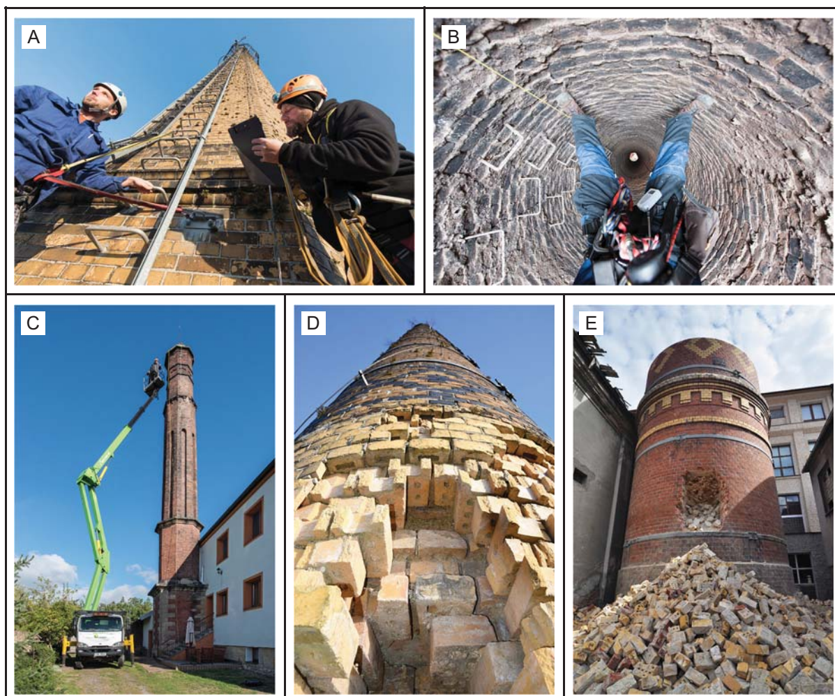
Obr. 3: Průzkumy v terénu. A: Průzkum a zaměření vnějšího pláště. Tkalcovna, C. A. Preibisch, Dětřichov (→ 50). B: Průzkum a zaměření průduchu. Cukrovar, Čelechovice na Hané (→ 181). C: Průzkum komína z vysokozdvížné plošiny. Důl bratří Bartelmů, Ruda (→ 7). D: Identifikace typu cihel v rozbořeném zdivu dřívku. Textilní továrna, Šluknov (→ 1977). E: Zkoumání konstrukce a materiálu při demolici komína a odběr cihel. Přádělna, Broumov (→ 3547).
