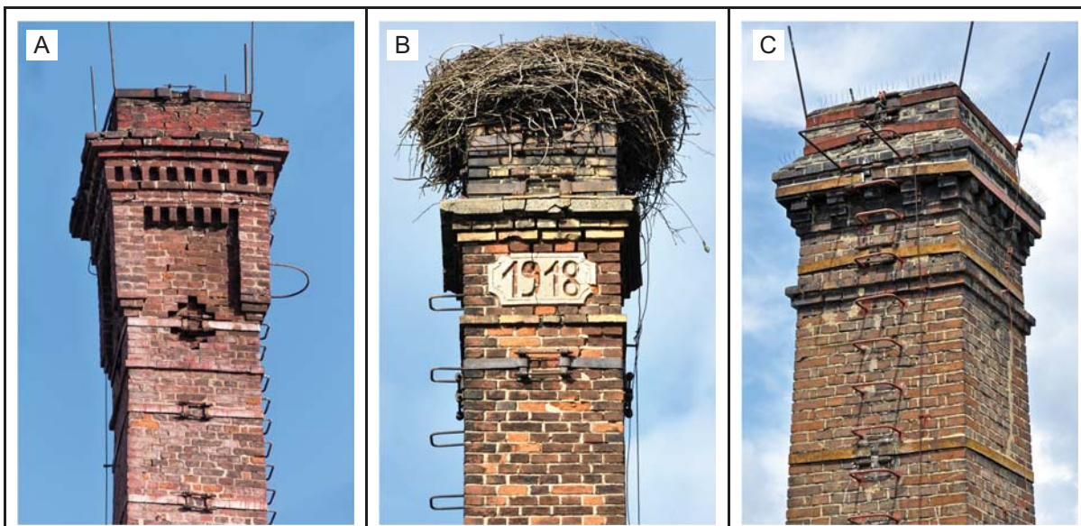
Obr. 42: Hlavice čtyřbokých komínů. A: Barvírna, Robert Anton Hoffmann, Liberec III-Jeřáb. B: Lihovar, Chotýšany. C: Továrna na uzené zboží, Josef Jeřábek, Praha 7-Holešovice.
