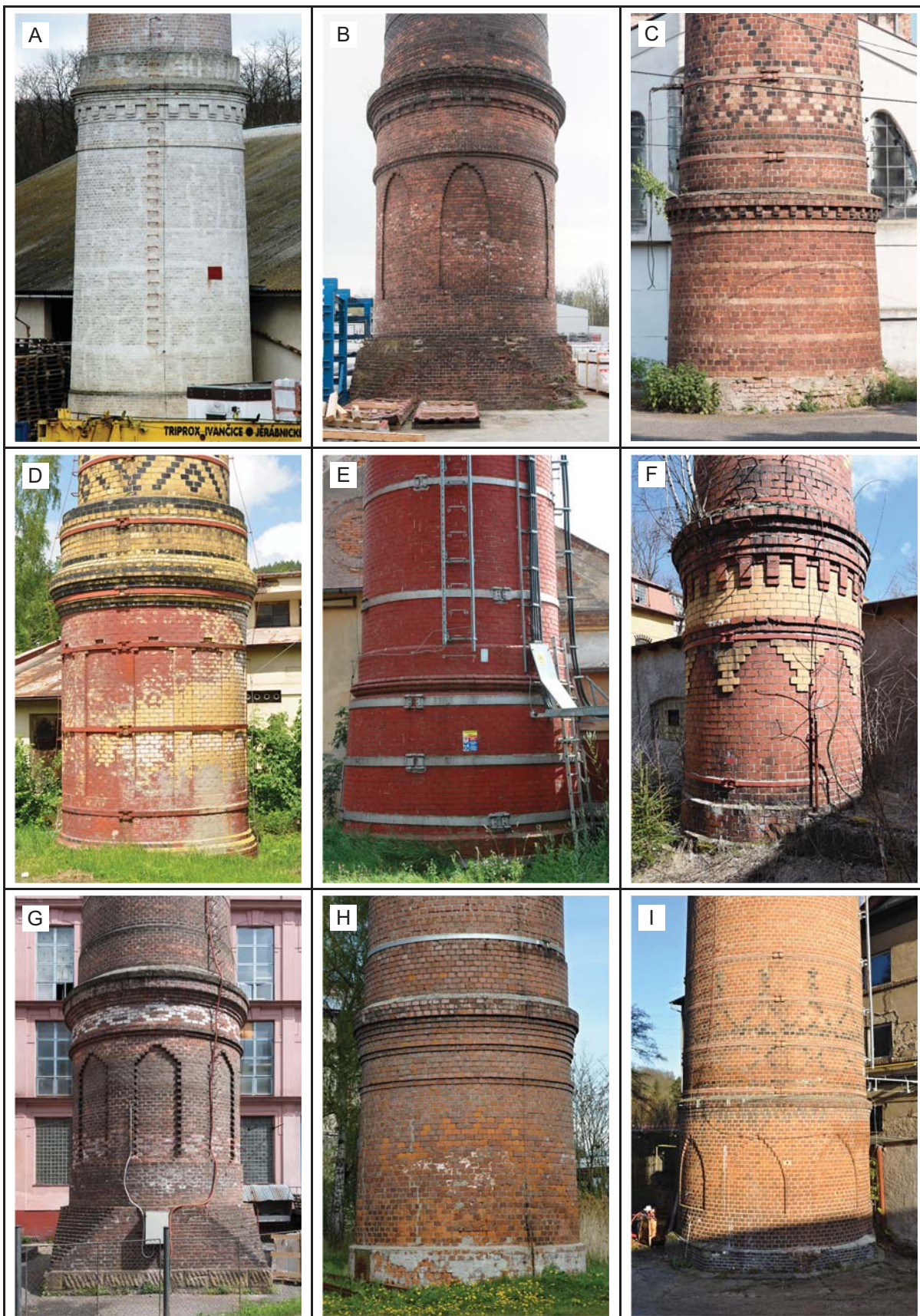
Obr. 32: Oblé podstavce. A: Cihelna, Ivančice. B: Důl Michálka, Ostrava-Slezská Ostrava. C: První severočeský akční pivovar, Bohušovice nad Ohří (→ 111). D: Sklářny Kavalier – huť Josef, Sázava (→ 12). E: Textilní továrna, Nové Kocbeře. F: Továrna na perličkové kabelky, A. Salzer, Vejprty. G: Mechanická tkalcovna, Košťálov. H: Uhelný hlubinný důl Mayrau, Vinařice. I: Elektrárna, Dražice.
