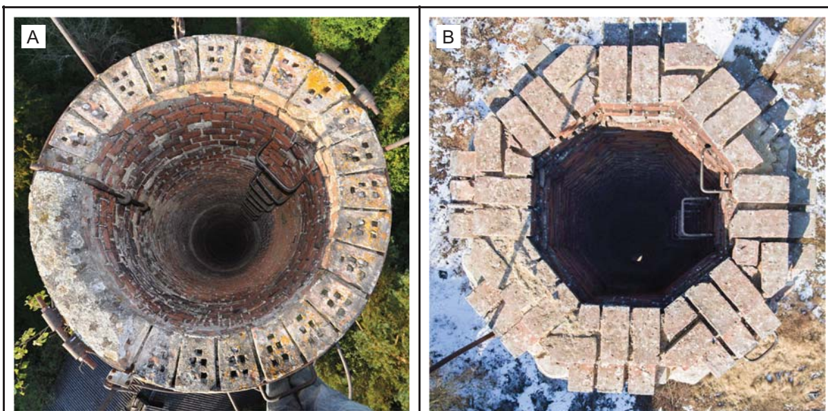
Obr. 73: Typický problém současnosti: narušené, nebo zcela chybějící ukončení hlavy komínů a probíhající degradační procesy. A: Cihelna, Řehenice-Babice. B: Cihelna, Emanuel Klotz a spol., Plzeň-Bolevec (→ 145).
