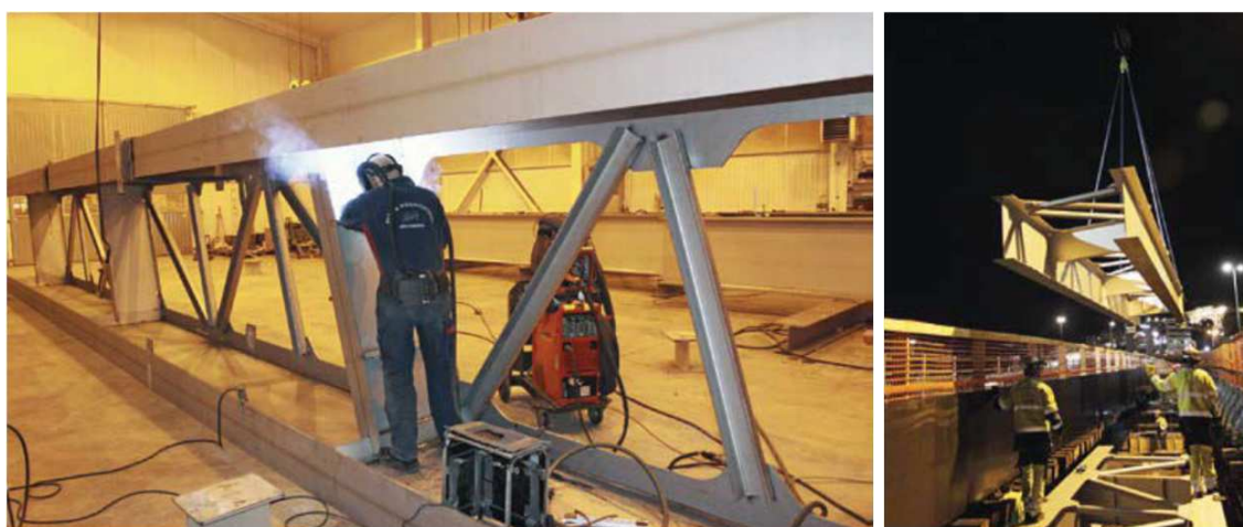
Obr. 2 Ocelový nosník železničního mostu ve Stockholmu během výroby (vlevo) a při montáži (vpravo) (foto: Lars Hamrebjörk)
