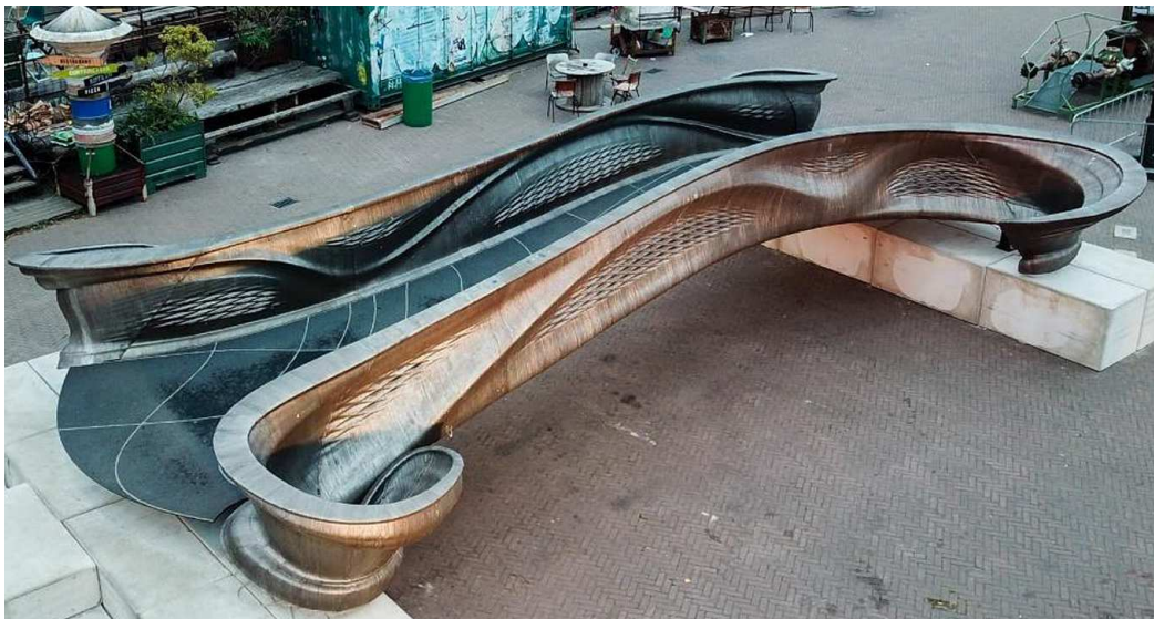
Obr. 44 Lávka MX3D z korozivzdorné oceli vyrobená technologií 3D tisku [18]
