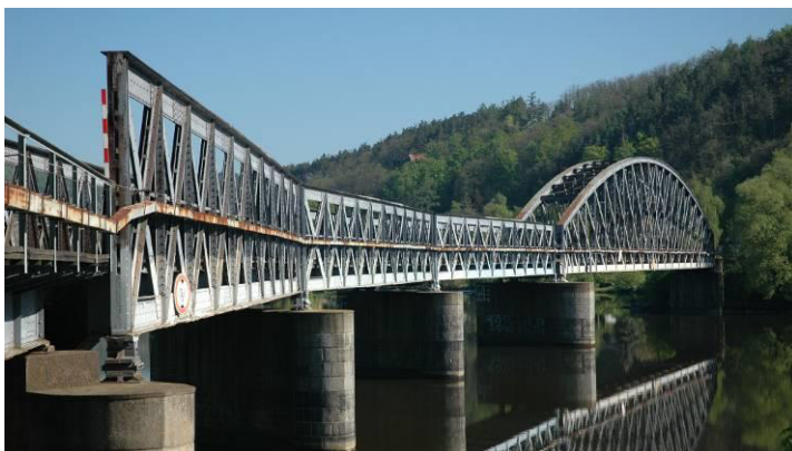
Obr. 4 Most ve Skochovicích
