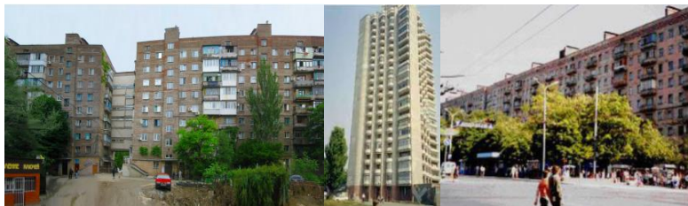
Obr. 1: Objekty postavené z alkalicky aktivovaného materiálu [6,7]
